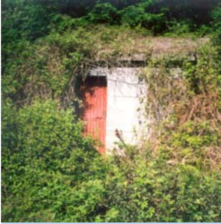
Captación Mal Protegida
